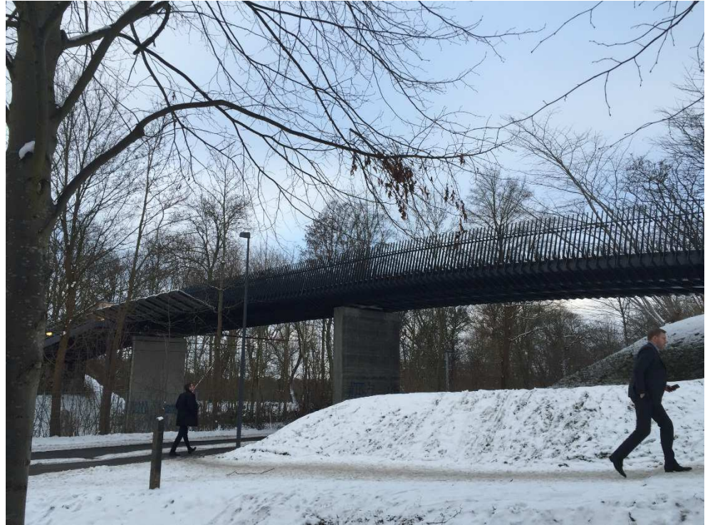
Figur 4 - Stibro over Husum Station; opført 2015.
