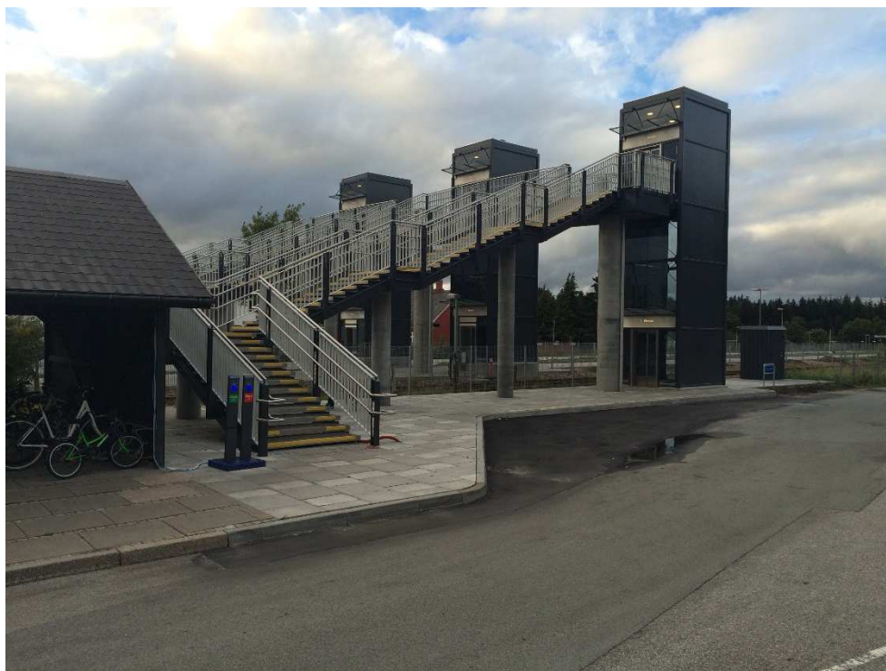
Figur 3 - Perronbro ved Skørping Station; opført 2014.
