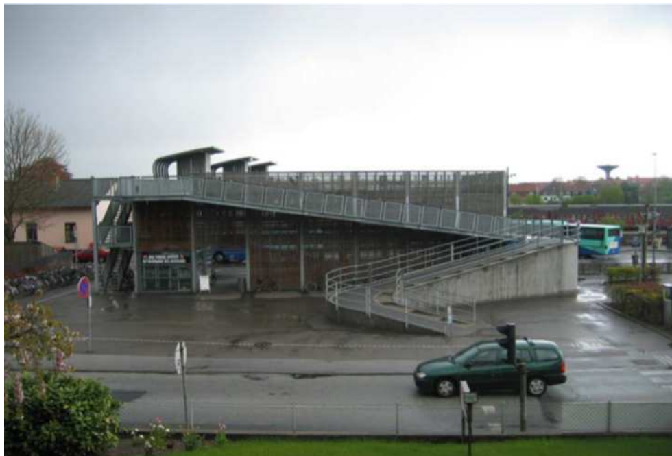
Figur 6 - Perronbro over Næstved Station; opført 2000.
